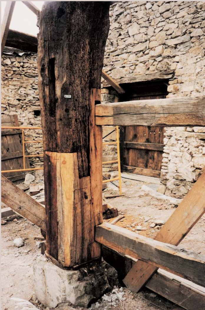
Zaharberitutako bi zutabe. Zutabe-oinek abereen eginkarien eraso kimikoa jasan zuten. Saneatu egin dira, eta osatu ere bai zur garbi nahiz zaharrezko osagarriak jarri.
