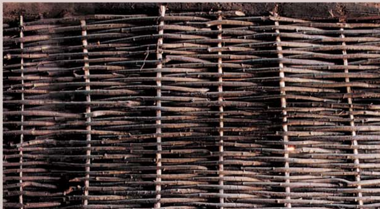
Hurritz hagazko bilbea goiko oineko itxitura baten goiko errematean. Karez luzitzen zituzten, eta horrenbestez igeltserotzako trenkada
