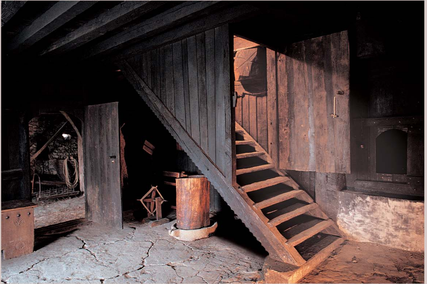
Desagertutako eskailera erreproduzitzen duena. Honen ondoan, buztin, errauts eta simaurrezko zorua.
