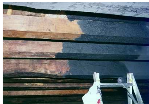
Aplicación de la costra negra en la cocina
