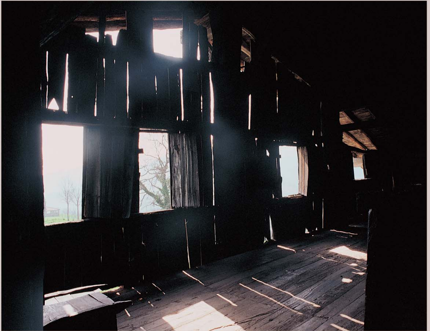
Aletegiak, etxean "ganbara berria" esaten zioten horrek, aireztapen etengabea zuen, eta leihoen bidez temperatura erregula zitekeen.
