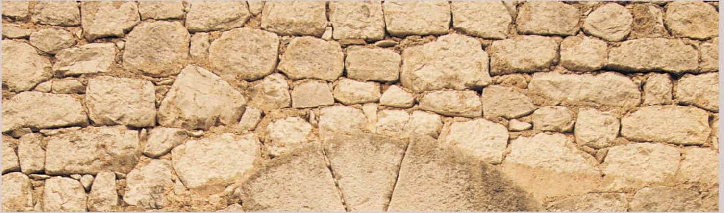
Tipo de aparejo de sillarejo gótico utilizado para la construcción de los primeros caseríos guipuzcoanos desde fines del siglo XV.
