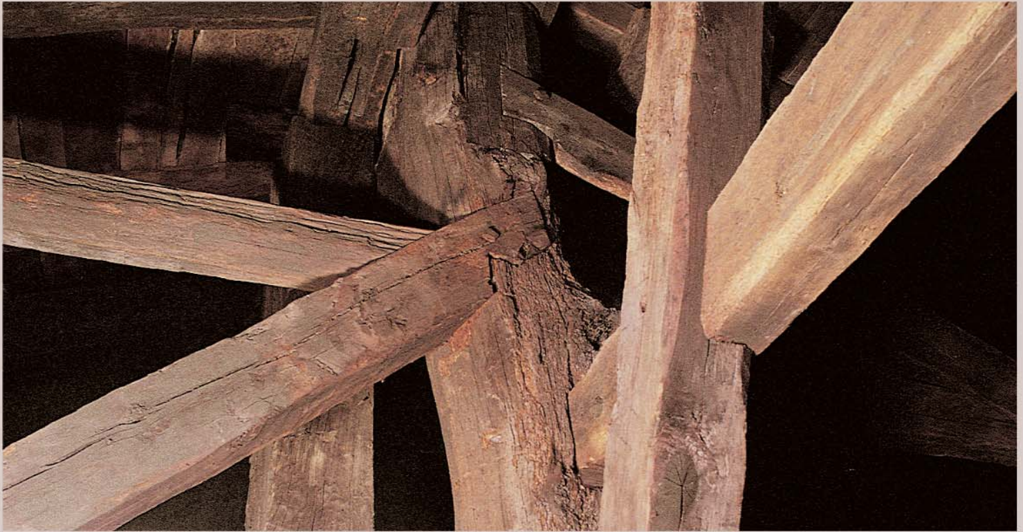
Habe etzanean eta zutabeen arteko loturak sendotzen dituzten jabaloietan jatorri alemaniarreko enara-mihiztadurak erabili zituzten.
