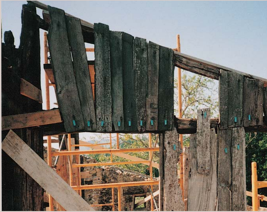
Baserría desmuntatzeko prozesua, zurezko piezak zenbakituta.
