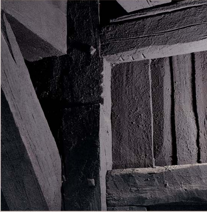
Zutabeko eta habeko mihizadura-kontramarkak, baserriaren egitura muntatzeko prozesuan gidari erabilitakoak.
