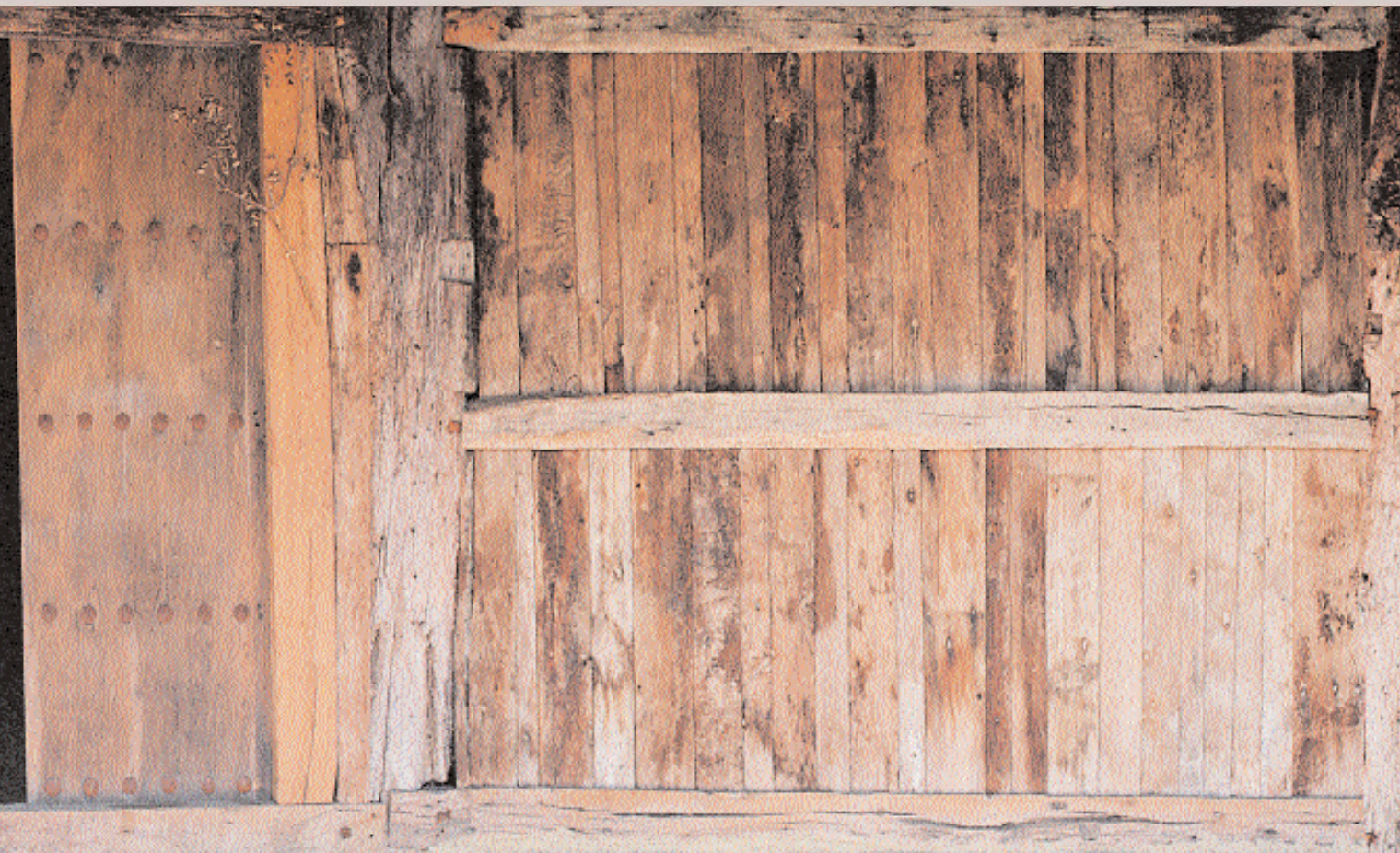
Reconstrucción de la fachada de madera del siglo XVI.
