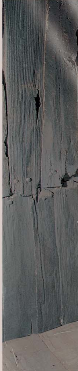
Detalle de la pared divisoria en la planta superior.
